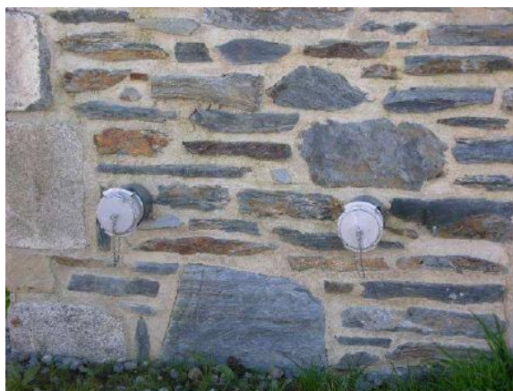
2 sorties de Ø 100 mm sur une réserve enterrée avec tenons verticaux et bouchons d'obturation
